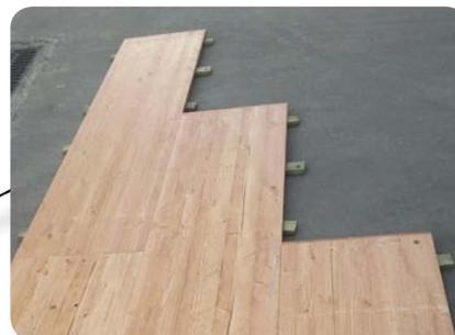
Le montage s'effectue en « mur de briques » avec des panneaux de 2 x 0,50 m et d'autres de 1 x 0,50 m.
