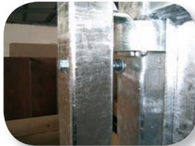
Les barres s'enfilent dans les ourlets des toiles pare-chute, puis s'installent sur les ergots des poteaux, et sont bloquées par un clip.
